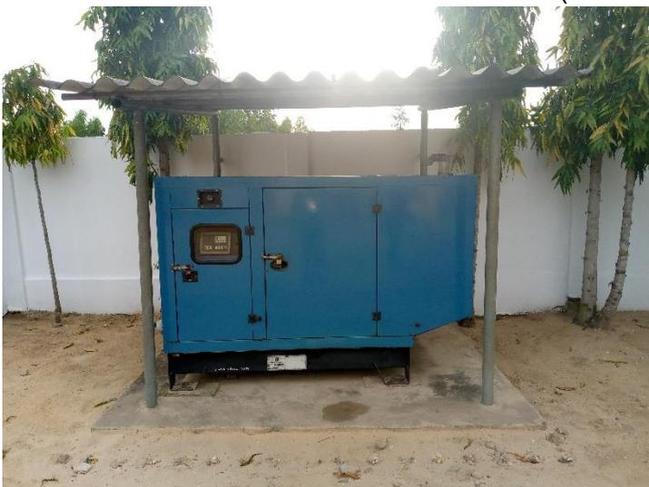
**Photo 10 :** Groupe électrogène automatique de relai du funérarium Le Pardon (Sèmè-Podji)
